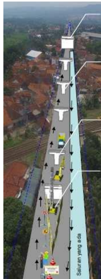
Gambar 8. Metode kerja pembangunan Fly Over Kretek
